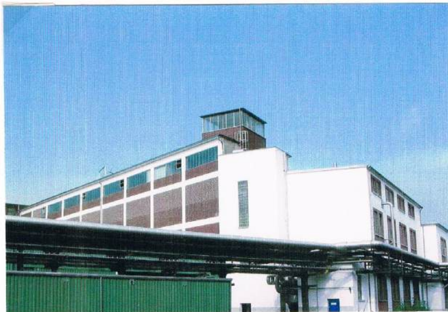
Heutiger Zustand des Gropius-Baues nach mehrmaligem Umbau
