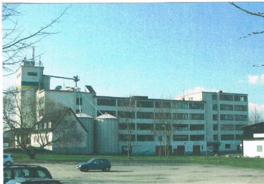
Firmengebäude des Landhandels Weiterer GmbH, Algemissen (vorm. Landhandel Gustav Ahlborn), jetzt mit Verwaltungsgebäude (links) und Getreidesilos (Foto: G.Schumann, 2007)
