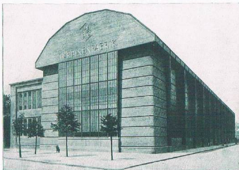
Turbinenhalle der A.E.G. Berlin
